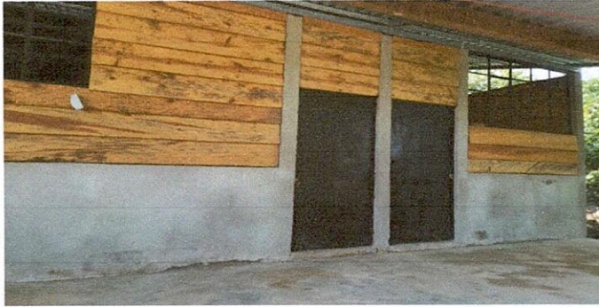
Foto1: Intervención de ventanas y puertas de metal
