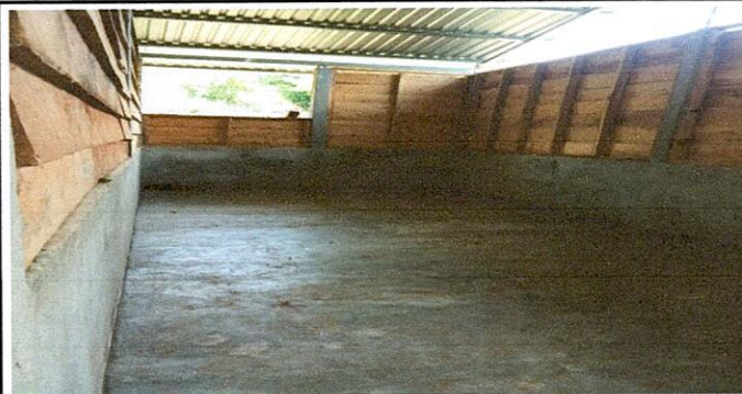
Foto 5: Área de piso ya cementado
